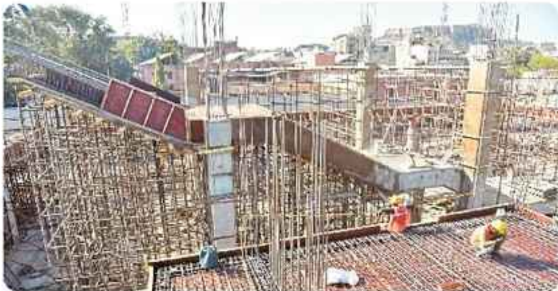
रेलवे स्टेशन के प्रथम द्वार पर चल रहा निर्माण कार्य।
